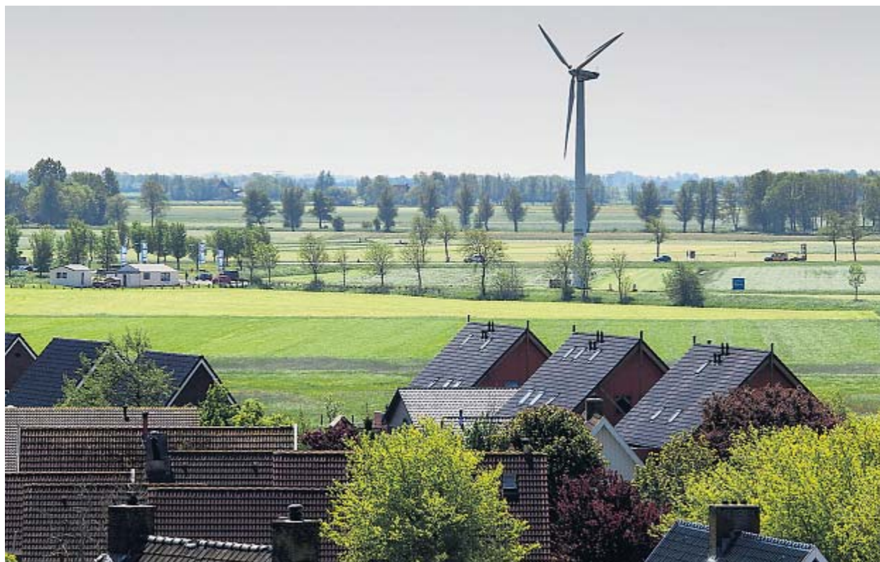
Zoals de Reduzumers profiteren van de eigen dorpsmolens, mogen alle Friezen straks meeprofiten van de nieuwe windparken.
